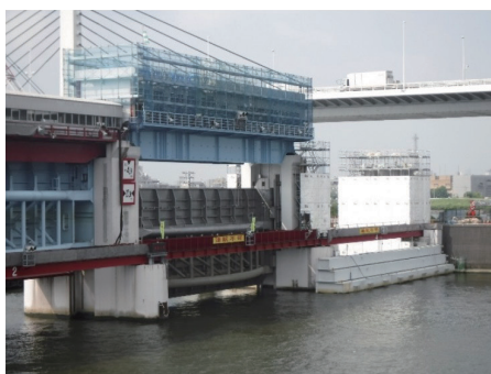
写真1.上平井水門3号門扉の外観(写真中央)
