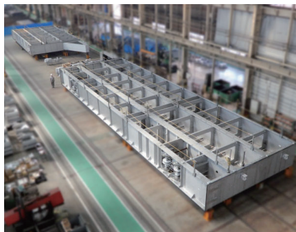
写真2.製作中の陸開門(手前1号、奥7号)
