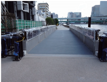
写真2.完成したテラス橋(北側より南向き)
