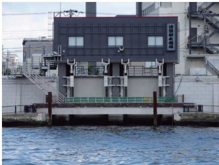
写真1.完成したテラス橋(隅田川の対岸より)
