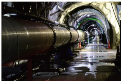
(図1) 超高真空ダクト (長さ3,000mのステンレス製パイプ) (東京大学宇宙線研究所様ご提供)
