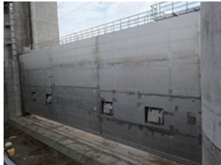
写真2.琴ノ浦水門の扉体(高9.5m×幅30m)
