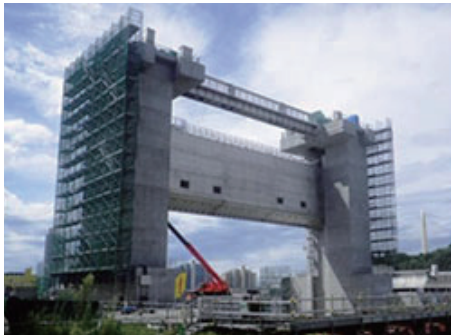
写真1.琴ノ浦水門の外観(完成直後)
