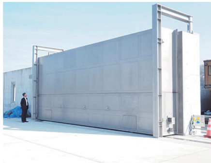
写真2.須賀陸閘8号(高4.1m×長10m)
