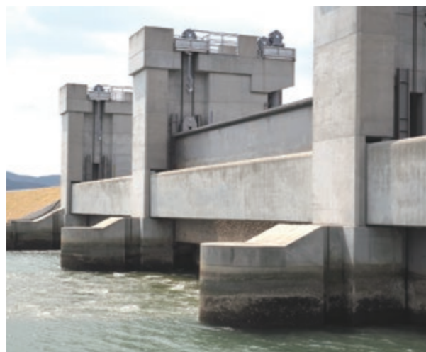
水門 (SUS304, NSSC2120, SUS316L, NSSC2304)
