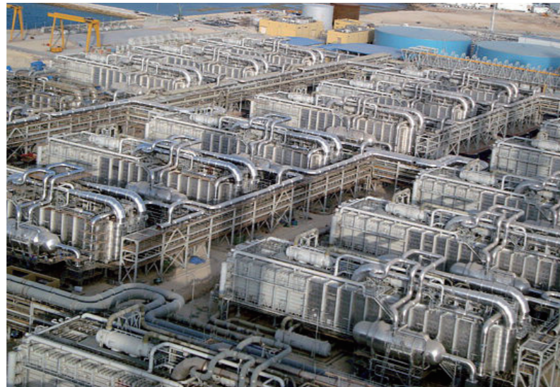
海水淡水化装置 (S32101, NSSC2120, NSSC2304, S31803, S32205, S32750, S31254)
