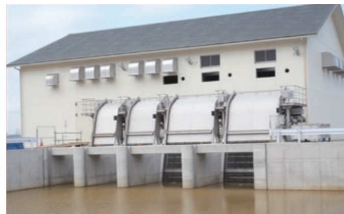
排水機場、除塵機 (SUS304, NSSC2120, SUS316L, NSSC2304)
