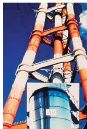
火力発電所煙突内筒
