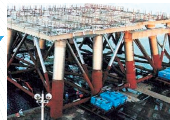
鉄構海洋構造物(ライニング)
