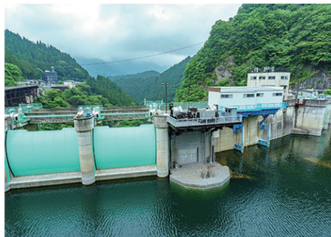
写真2.取水設備可動フレーム(据付中) (写真提供:(株)IHIインフラシステム殿)
