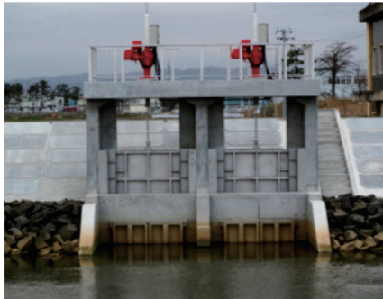
相の釜排水機場 排水樋門
